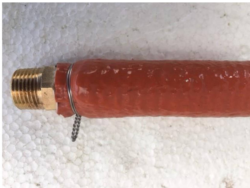
Bilde 5. Korrekt montert brannmantel over slangeklemme, sikret med rustfri sikringstråd.
